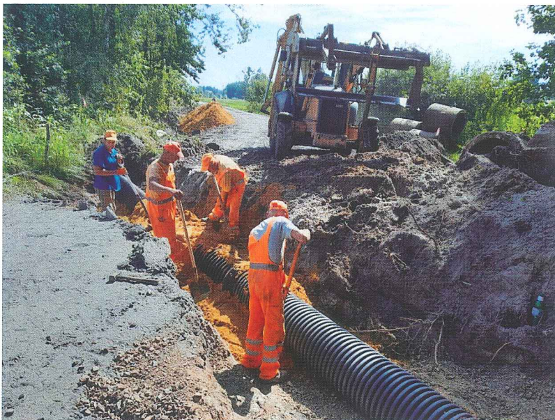
Realizacja zagospodarowania poscaleniowego, obiekt Babsk, pow. włodawski:
