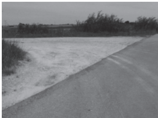
Droga przed modernizacją.
