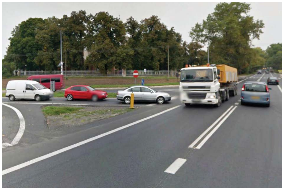
Skrzyżowanie drogi 747 z S 19 doczeka się przebudowy w 2014 r.
